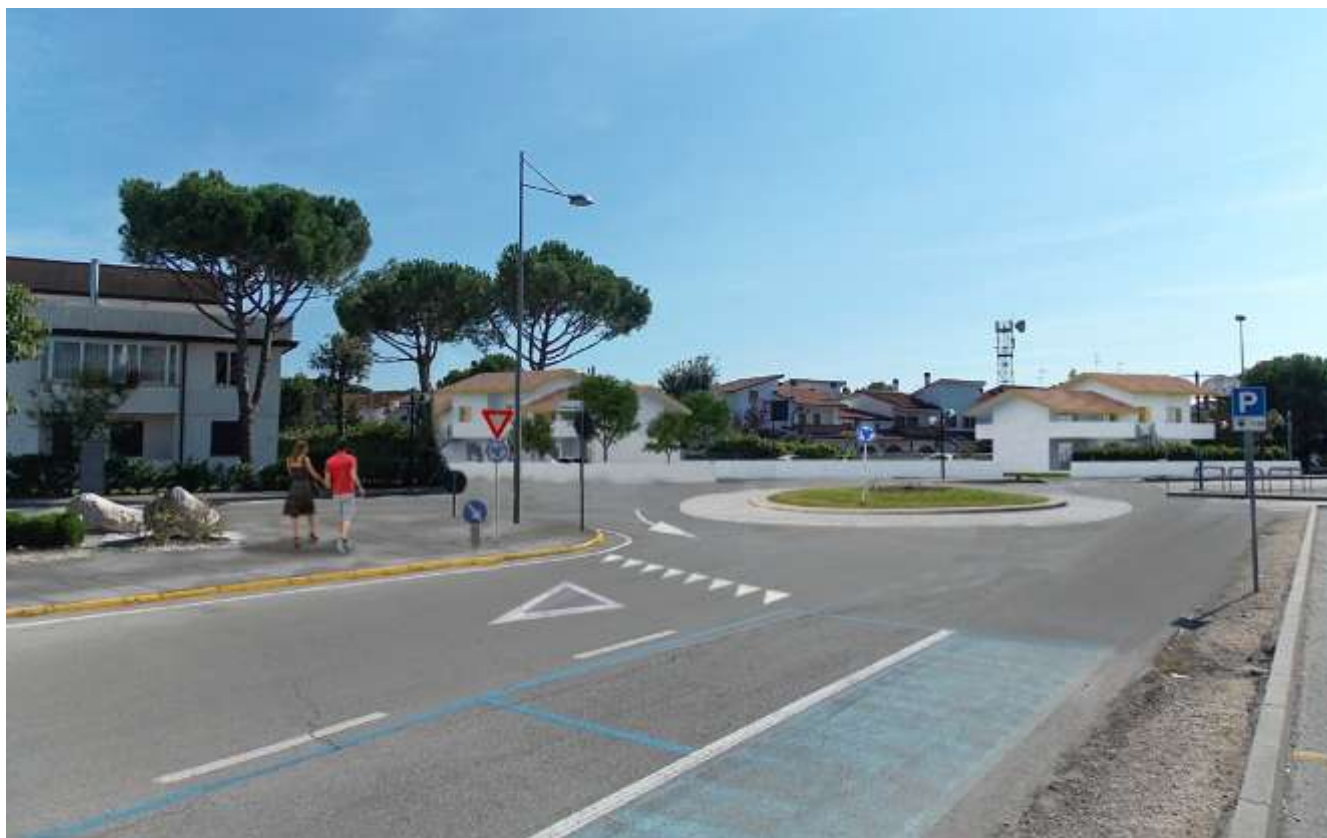
vista da via Livenzuola il nuovo assetto dell'intersezione stradale
